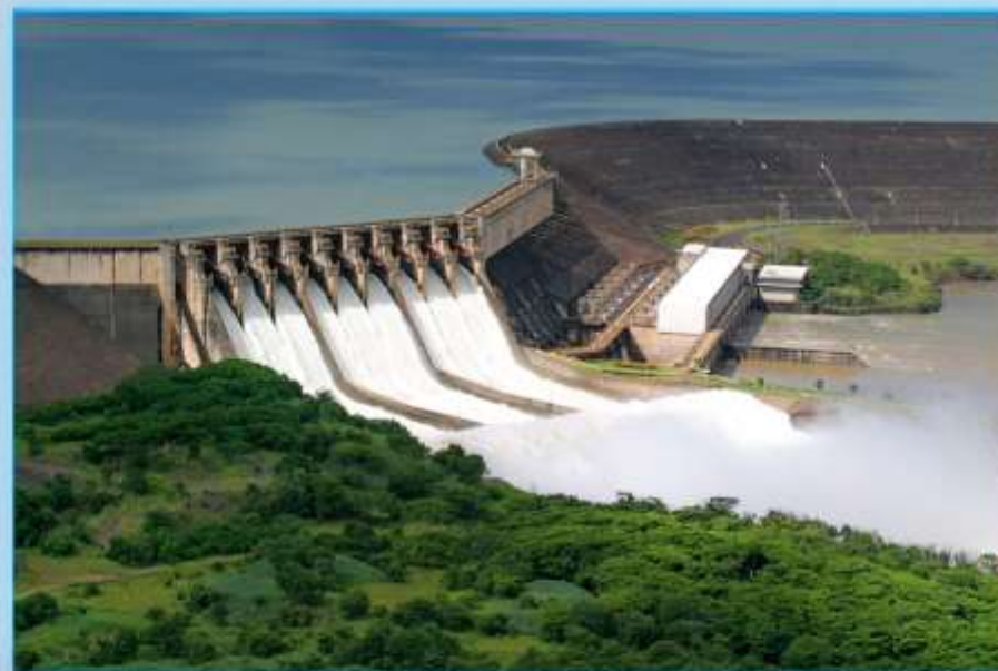
Hidroelétrica pequena (CGH)
