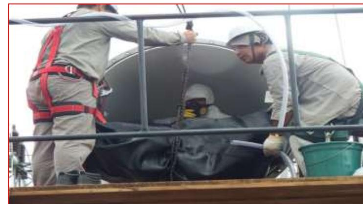
Retirada da bolsa danificada do interior do tanque conservador
