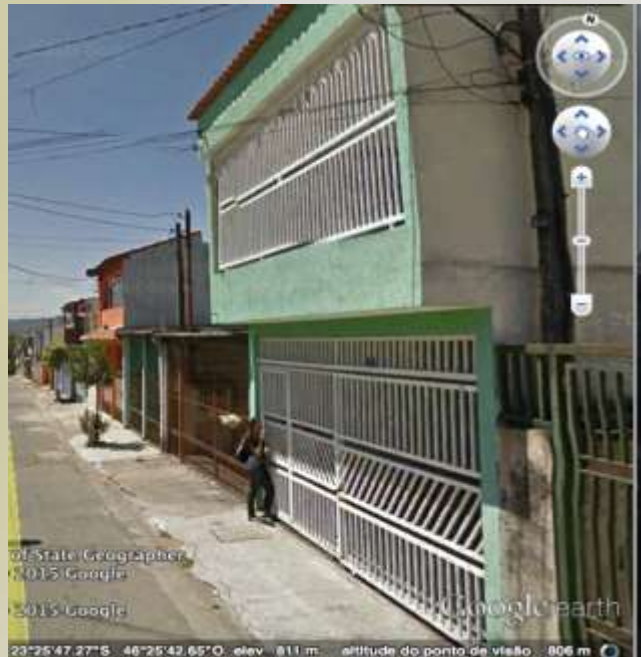
Obstruções por grades e caixas metálicas
