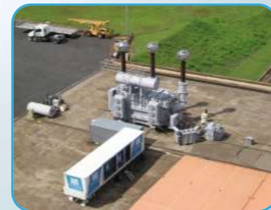
Serviços de Reforma e Repotenciação
