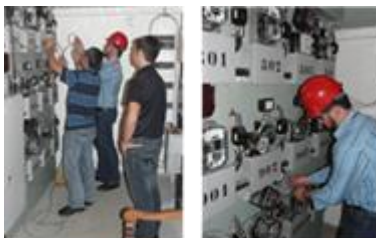
Instalação do Piloto
