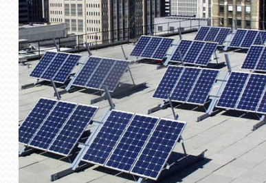
Conexão a rede
